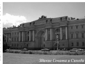
Здание Сената и Синода
