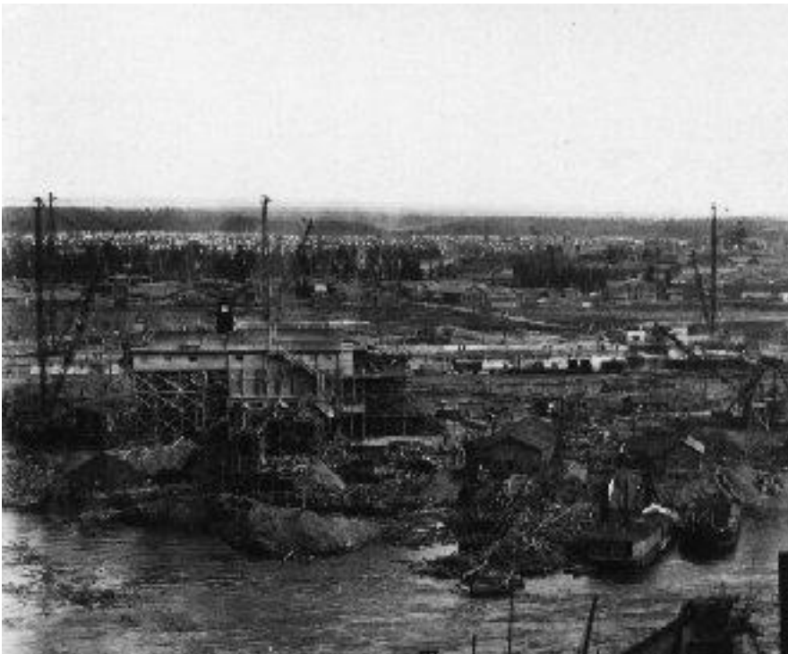
Строительство Свирьской ГЭС
